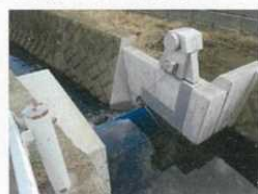
【取水堰を転角落しから倒ゲートに改修】
