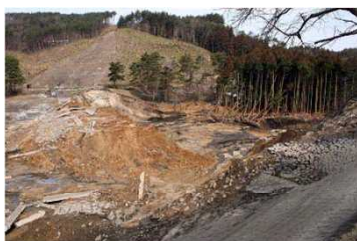
堰堤の右岸が決壊
