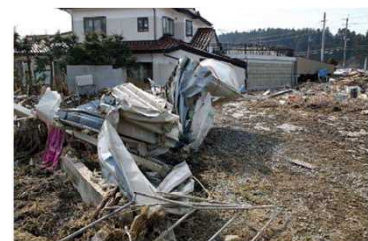
洪水による建物の被害
