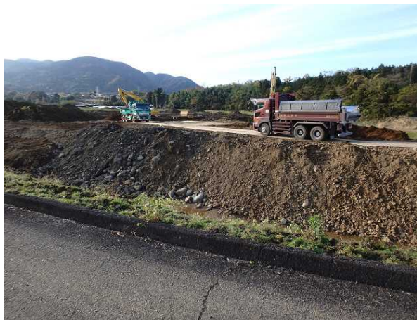
搬入した礫質土（水田基盤材）
